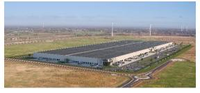
solaires d'une superficie de non moins de 150 000 m², soit une capacité de production d'énergie verte de 25 MWp.²
